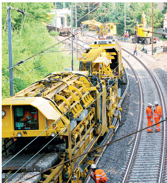
Suite Rapide. Per sette anni Gcf avrà impegnate in Francia due "officine mobili": convogli di treni e macchine operatrici ad alto rendimento in grado di consegnare un chilometro di linea rinnovata a giorno
