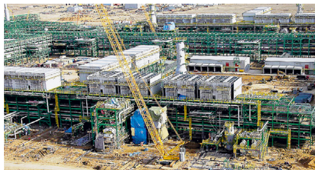
Bonatti Un'immagine di costruzione impianti da parte del gruppo parmigiano.
