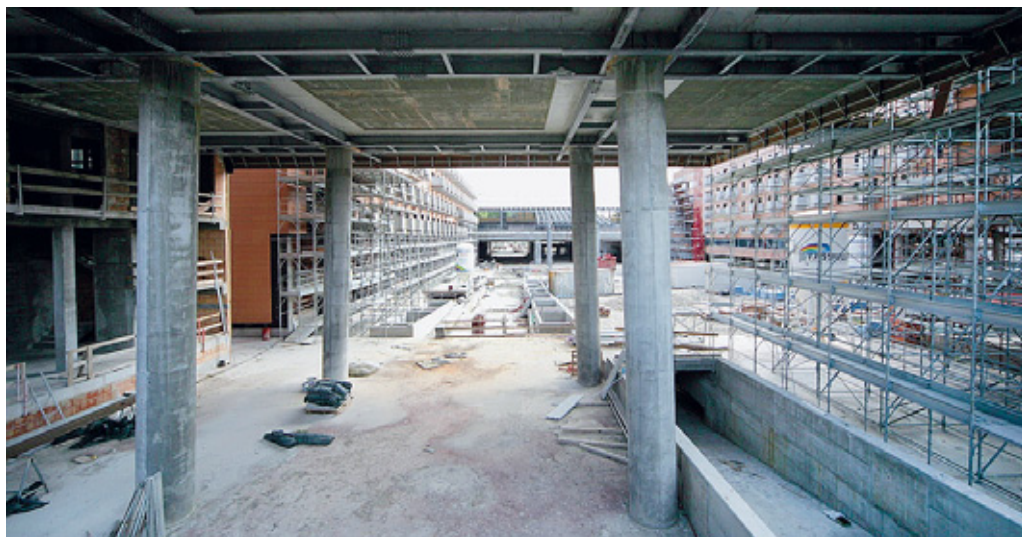
Lavori in corso Una buona notizia: i lavori per la stazione sono ripartiti dopo sette mesi di stop.
