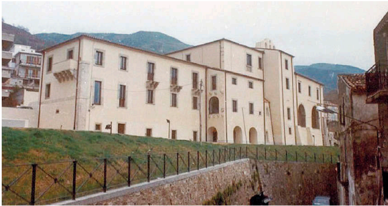
Il Complesso del Sant'Agostino, sede dell'amministrazione municipale. La politica guarda già alle elezioni comunali
