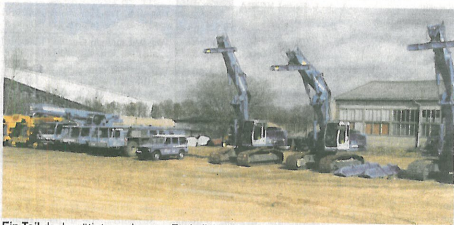
Ein Teil der benötigten schweren Technik ist bereits in Wittenburg angekommen.
