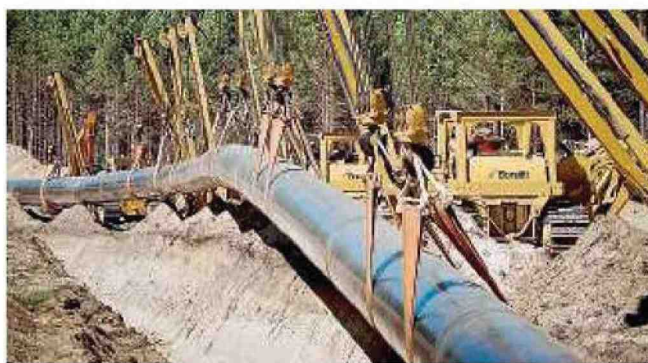
PIPELINE Un cantiere della Bonatti .
